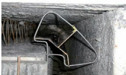
Eine weitere Befestigung ist durch die Eigenstabilität der Bleche nicht erforderlich. Die Fixierbügel können noch während des Betonvorgangs entfernt werden und mehrfach wieder eingesetzt werden.
