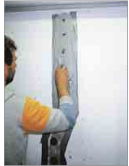
Klebpacker im Einsatz: Verdämmen des Risses
