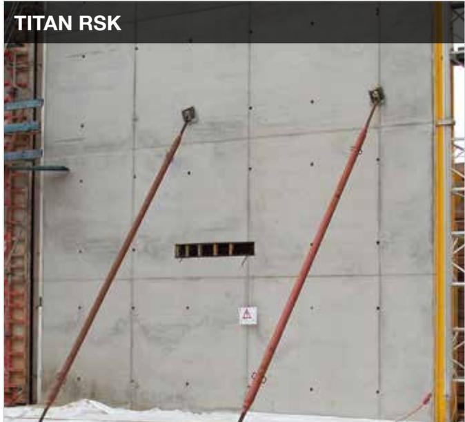
Die bewährte Schrägstütze mit Schnellverstellung
