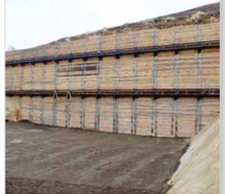
Die **Träger-Bohl-Wand** mit vorgehängten Holzbohlen und Bohlenverschlüssen ist bestens geeignet für tiefe Gräben und Baugruben im innerstädtischen Bereich. Das System besteht aus nur drei Teilen:
