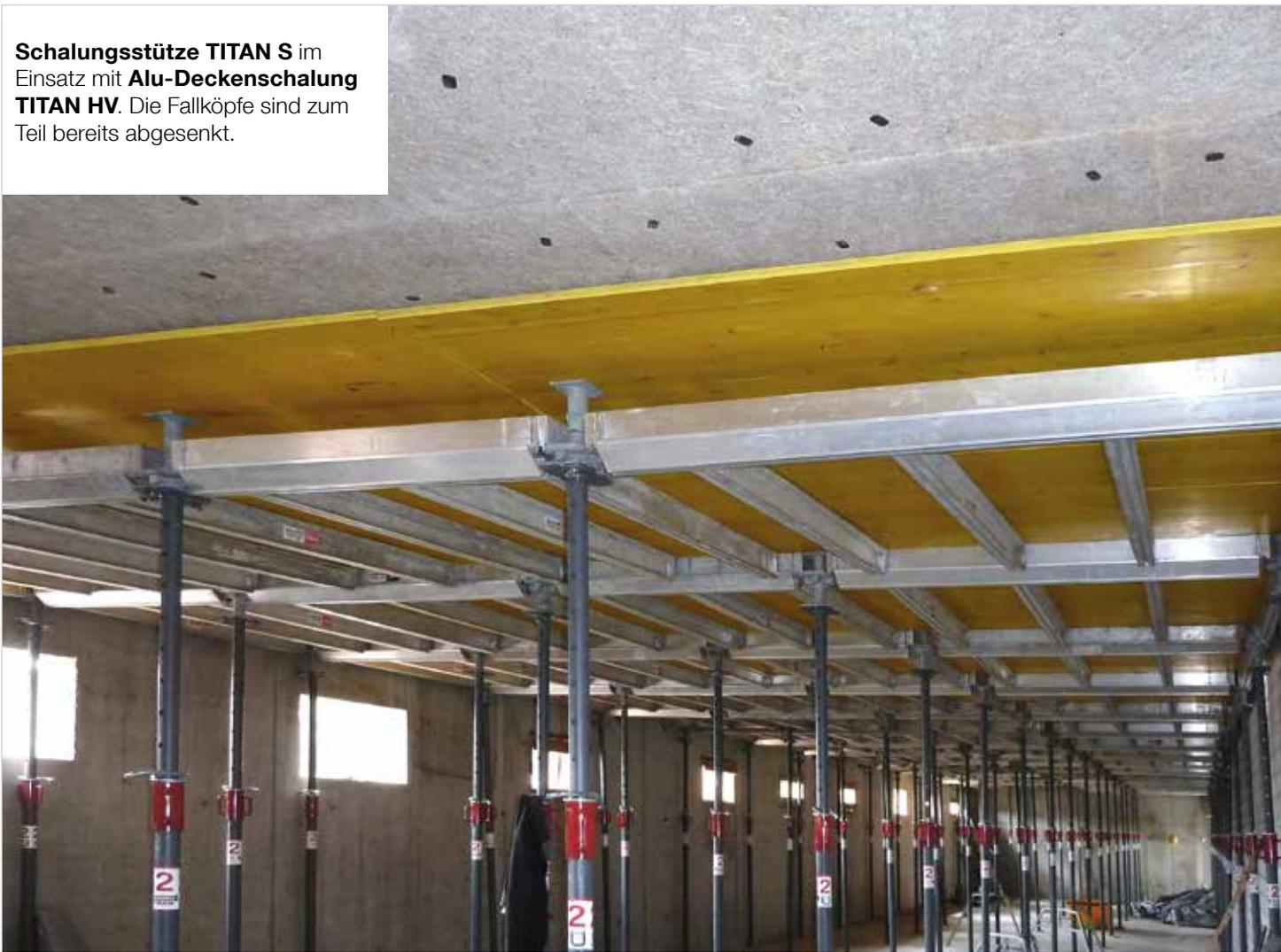
**Schalungsstütze TITAN S** im Einsatz mit **Alu-Schalungsträger TITAN 120** – Unterstützung zur Herstellung einer Kellerdecke mit Halbfertigteildecken.
