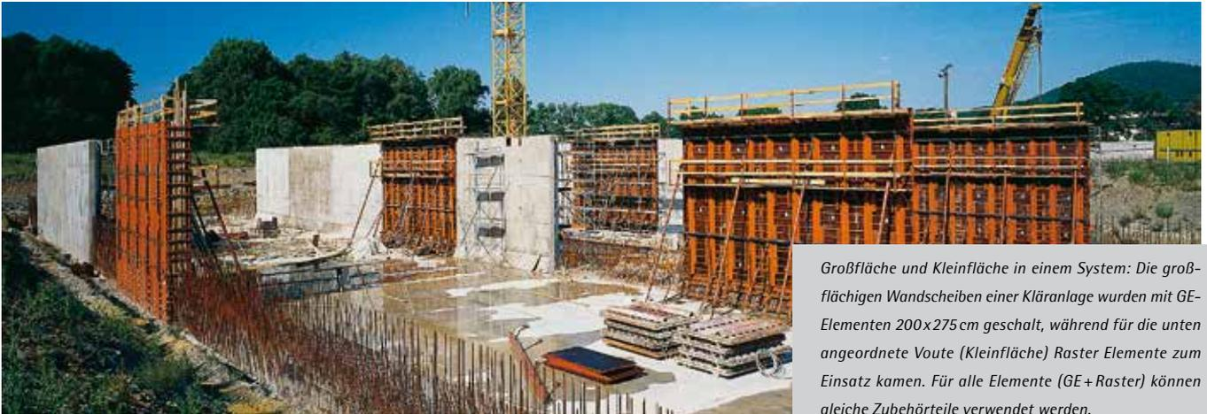
Großfläche und Kleinfläche in einem System: Die großflächigen Wandscheiben einer Kläranlage wurden mit GE-Elementen 200x275 cm geschalt, während für die unten angeordnete Voute (Kleinfläche) Raster Elemente zum Einsatz kamen. Für alle Elemente (GE+Raster) können gleiche Zubehörteile verwendet werden.
