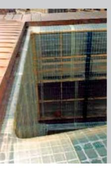
Bei zugfester Verbindung mit dem Bauwerk, was durch Aufnageln oder Aufschießen eines Brettes durch das Pecafil ins Mauerwerk oder in den Betonuntergrund geschehen kann, dient Pecafil-Wetterschutzmaterial gleichzeitig als Absturzsicherung. Die Drahteinlage wirkt gleichermaßen auch einbruchshemmend.
