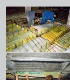
Für Baugrubenverbau wird hauptsächlich Pecafil VR10 verwendet. Es besteht aus einer Sonderstahlmatte im Raster von 150 x 75 mm. Die verwendete Schrumpffolie besteht aus Polyethylen. Sie ist ungiftig und grundwasserneutral.
