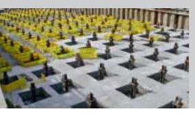
Dem schnellen Einschalen folgt nach dem Betonieren das ebenso schnelle Ausschalen und Umsetzen für den nächsten Einsatz. Ein Reinigen der Schalung ist nicht erforderlich, da sich an der glatten Folie kein Beton festsetzen kann. Aus diesem Grund kann auch auf den Einsatz von Trennmitteln komplett verzichtet werden. Die Einsatzhäufigkeit liegt wiederum bei ca. 5 Mal. Pecafil kann sowohl als Positiv- als auch als Negativ-Schalung eingesetzt werden.
