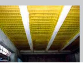
Verlegt werden die Verdrängungskörper auf einer durchgehenden Schalung. Auf die Unterkonstruktion genagelte Zwangsleisten dienen zur Aussteifung der Längsseiten. Das Ablängen der Pecafil-Verdrängungskörper erfolgt mittels Messer für die Folie und Bolzenschneider für die Drahteinlage oder mit dem Winkelschneider.
