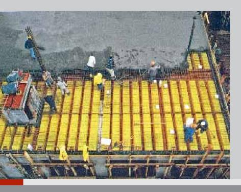
Pecafil-Verdrängungskörper für Rippendecken werden je nach Anforderung aus VR8 oder VR10 Universal-Schalmaterial hergestellt und fertig gebogen geliefert. Die beidseitigen Enddeckel können aus Pecafil-Schalstreifen oder aus Holz bestehen. Die Pecafil-Enddeckel sind Uförmig gebogen und werden über den Verdrängungskörper gestülpt. Die Holz-Enddeckel haben das Innenmaß des Verdrängungskörpers und werden mit Drahtstiften befestigt.
