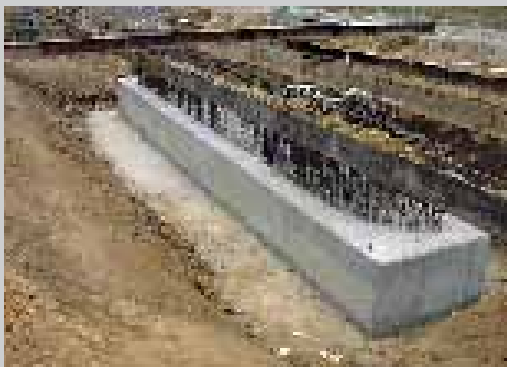
Pfahlkopfbalken bei Mittelpfeiler
