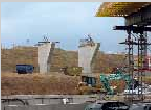
Brückenpfeiler einer Autobahnüberführung
