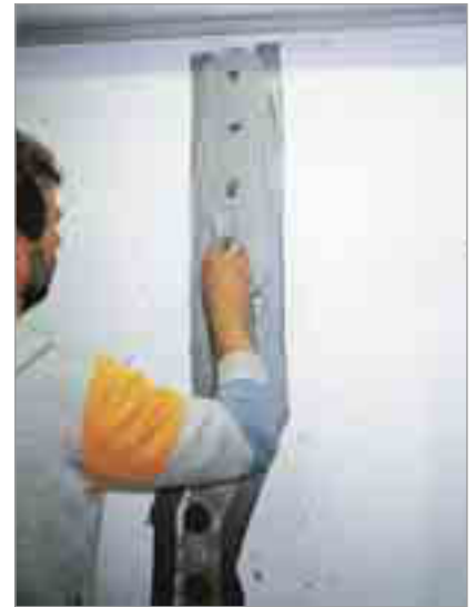
Klebpacker im Einsatz: Verdämmen des Risses
