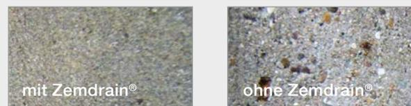
Bild 1: Optischer Unterschied zwischen mit und ohne Zemdrain® betonierten Wänden in der Kläranlage Offenburg nach 10-jähriger Betriebszeit.
